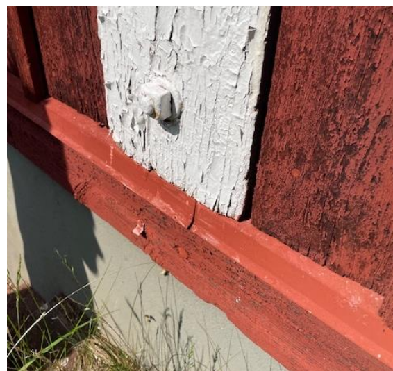
Figur 7. Plåt över offerbräda samt bult.
