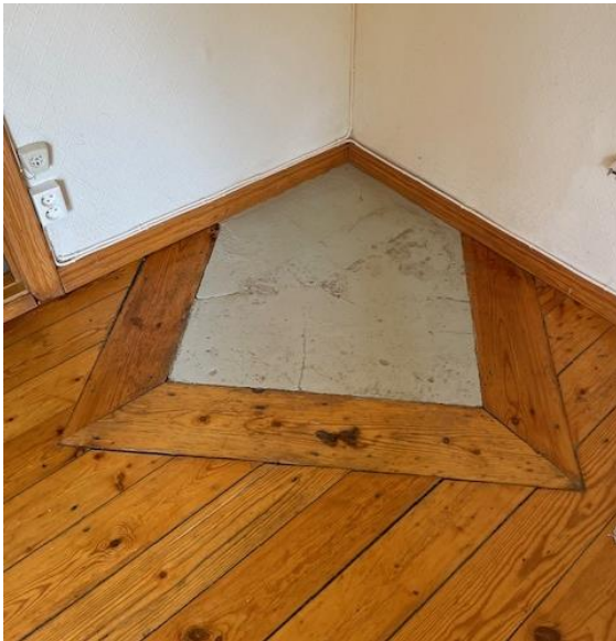
Figur 6. Underlag för eldstad i plankgolv.
